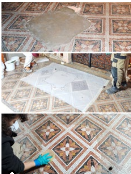
Les étapes de la restauration : lacune de départ, relevé au calque, dépose de la nouvelle mosaïque.
