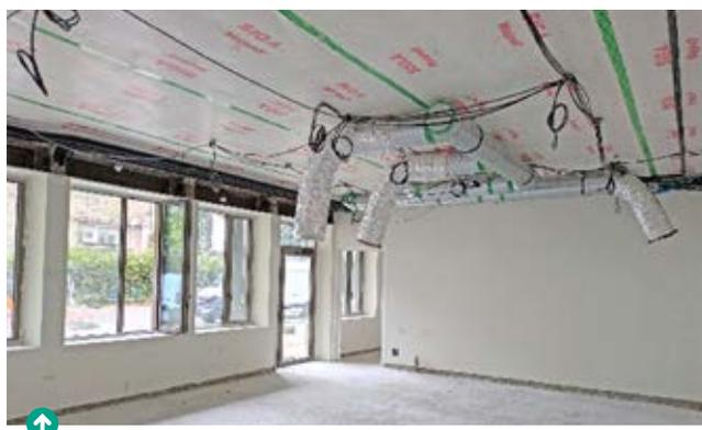
L'une des salles de classe fin août, avant la réfection des sols, peinture et du faux plafond qui cachera la ventilation double flux.
