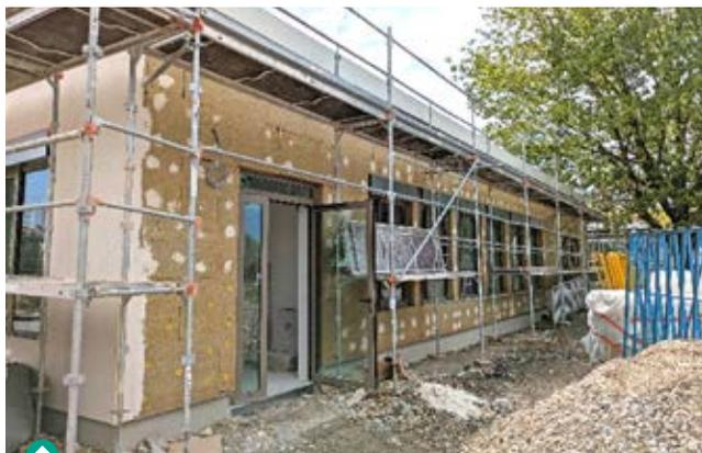
Pour de meilleures performances énergétiques, une isolation a été réalisée par l'extérieur et sous les toitures.
