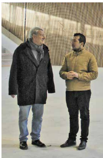
Visite de chantier du gymnase avec Erick Roizard élu référent et le directeur des services techniques.
