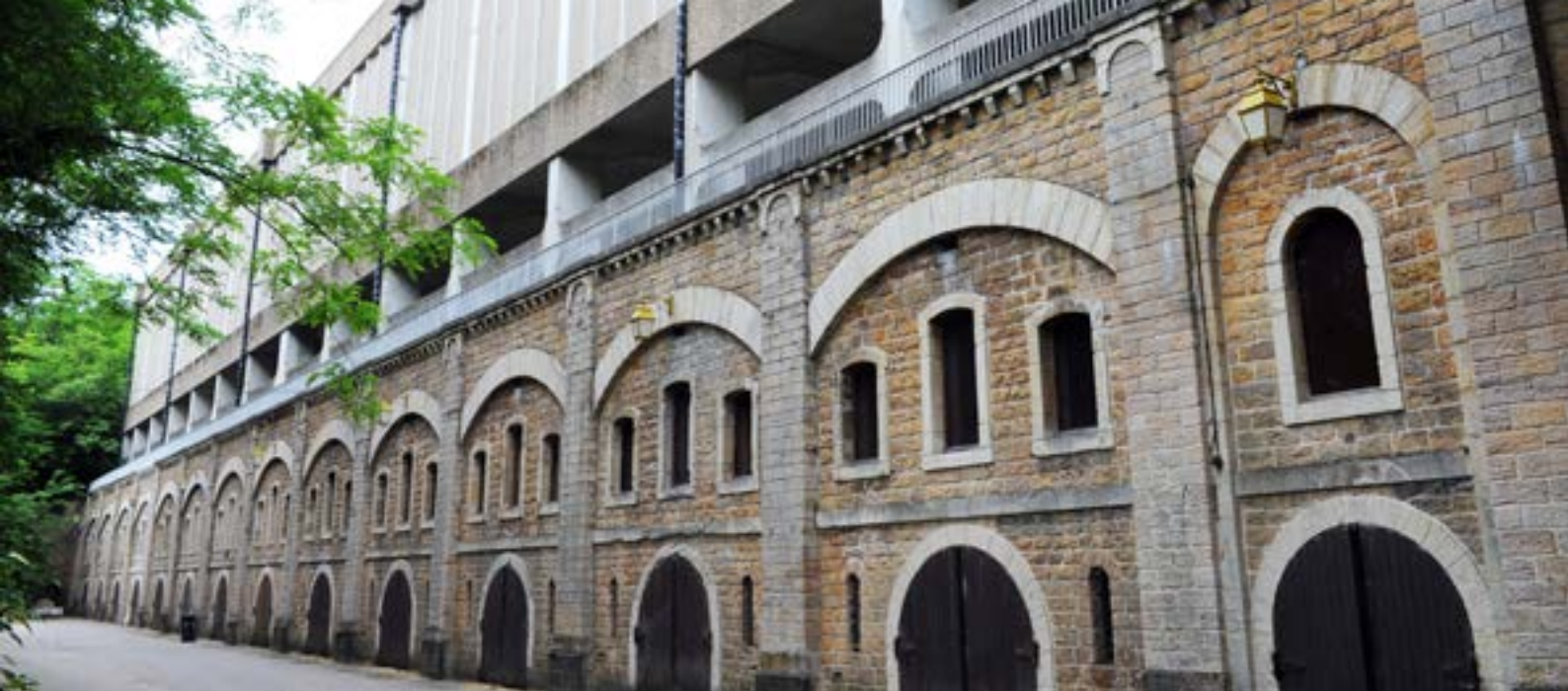
Château d'eau du Fort de Bron.
