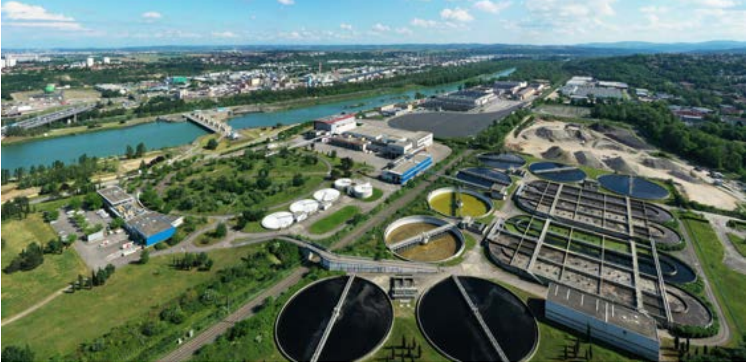
Station de traitement des eaux usées à Oullins-Pierre-Bénite.
