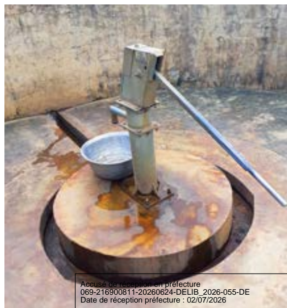
Forage équipé d'une pompe à motricité humaine.
