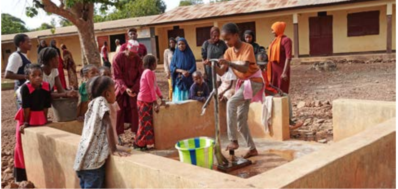
Forage équipé d'une pompe à motricité humaine (Guinée).
