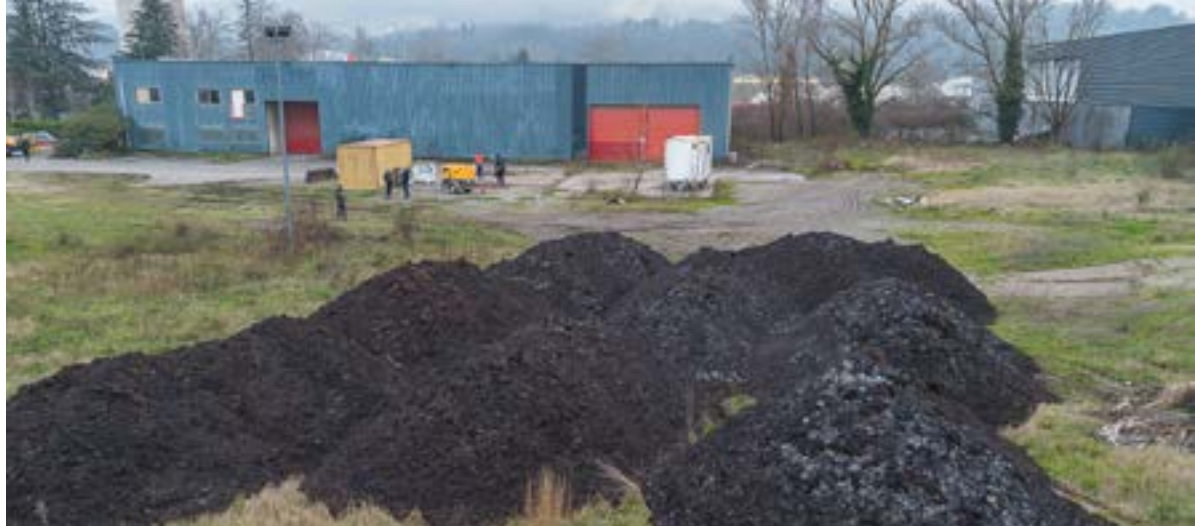
Utilisation de compost produit à partir de déchets alimentaires pour la renaturation d'un ancien site industriel à Genay.
