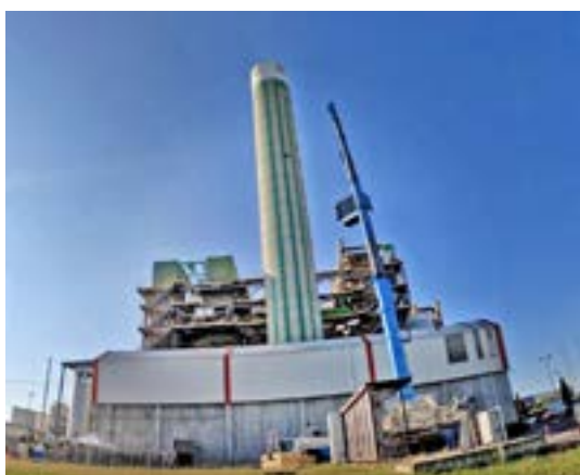
Travaux de remplacement de l'échangeur défectueux sur le traitement des fumées de l'une des lignes d'incinération de Lyon Sud.
