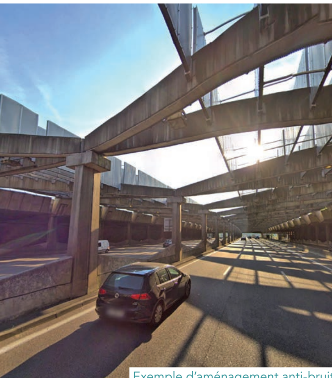
Exemple d'aménagement anti-bruit existant, les damiers phoniques en couverture de l'A86 à Vélizy (78)
