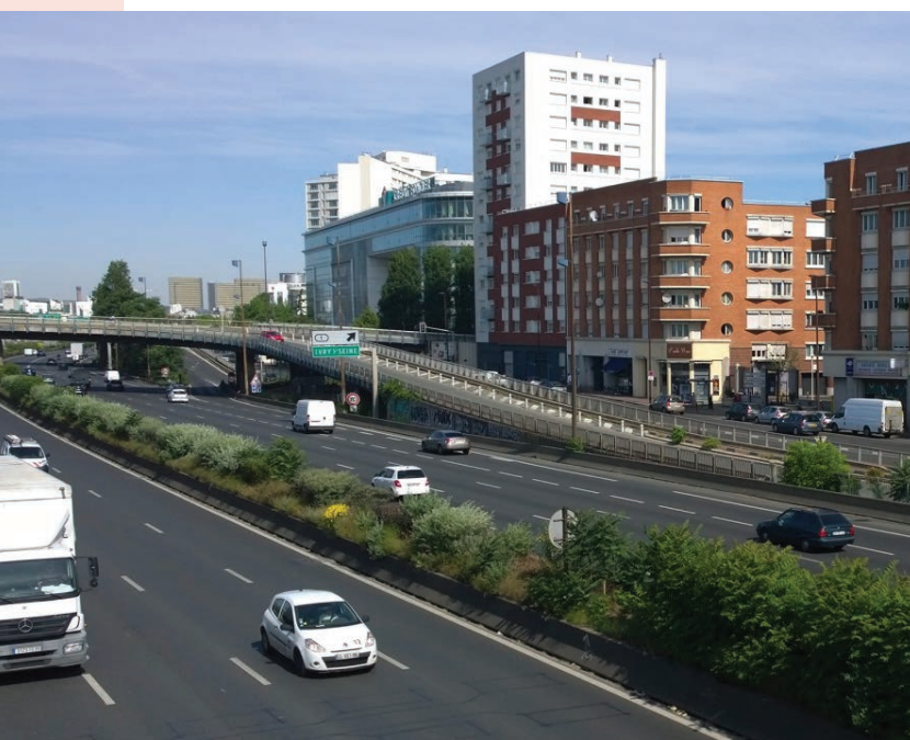
Des revêtements acoustiques peuvent limiter le bruit dans des zones de fort passage. Sur notre photo, expérimentation dans le Val de Marne.
