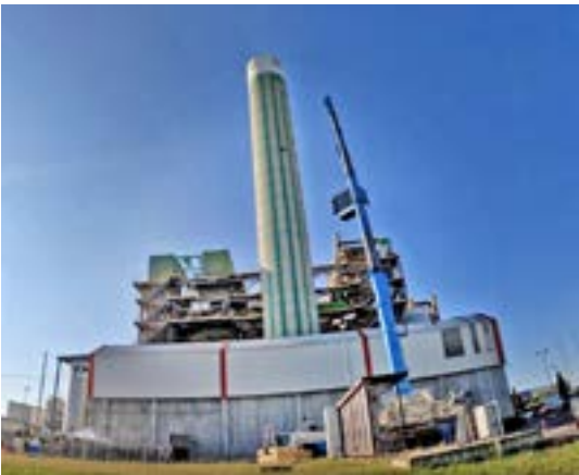
Travaux de remplacement de l'échangeur défectueux sur le traitement des fumées de l'une de lignes d'incinération de Lyon Sud.
