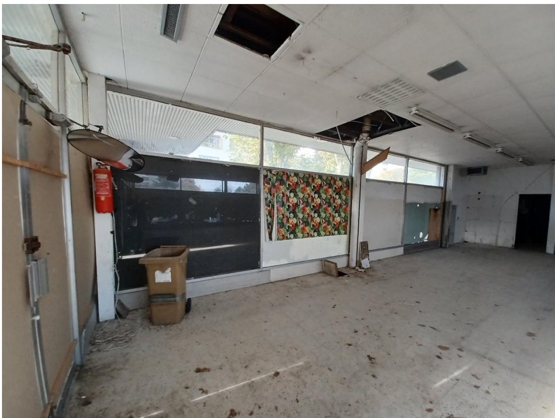
Vue intérieure – porte d'entrée
