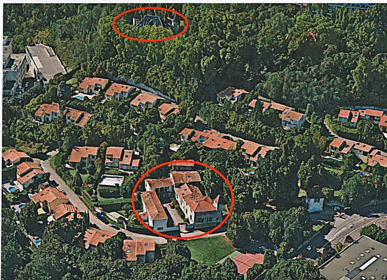
Le Treuil en 2025, entouré d'un lotissement et dominé par le château Récamier
